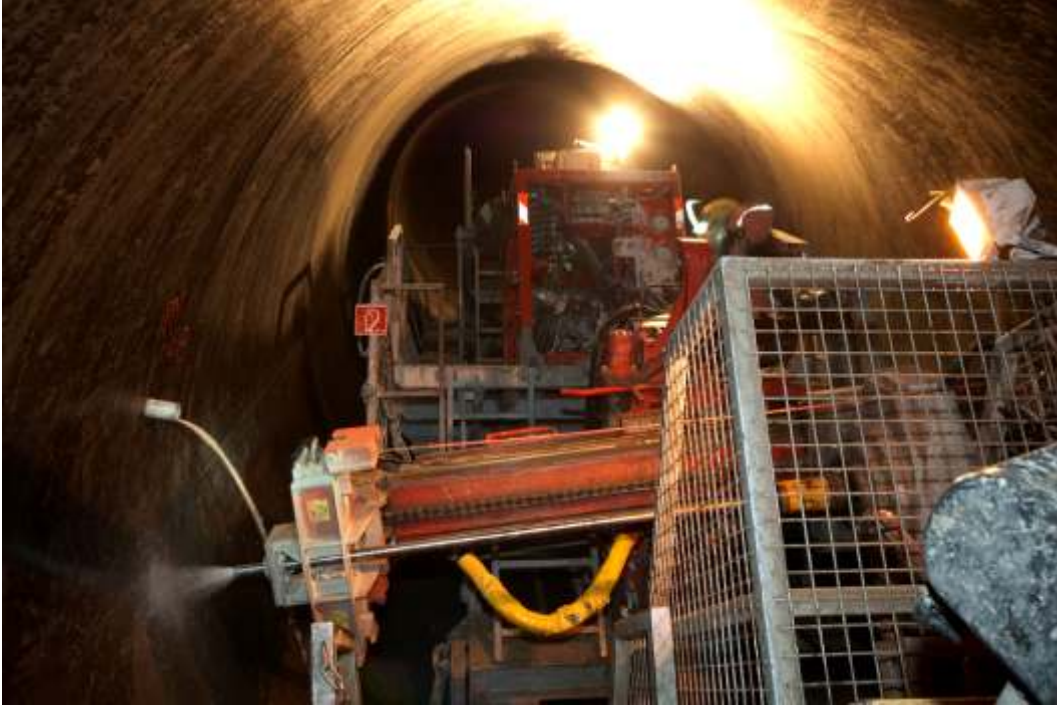
Foreuse en travail dans la conduite forcée
