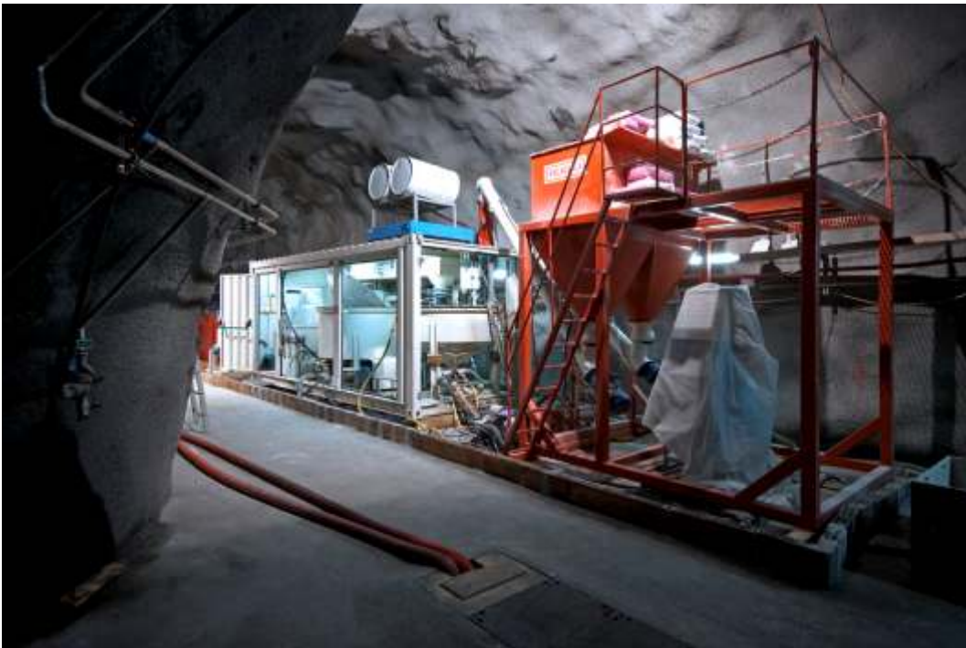
Plant de malaxage et injection en caverne
